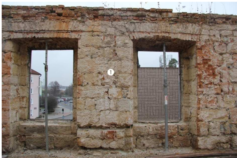
/204/ Jižní stěna. Úsek v rozsahu 5. a 6. okna zprava. ① pozice zaniklé hloubkové zdi/příčky
