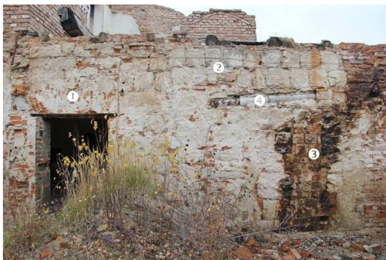
/204/ Severní stěna, úsek vpravo od 5. vstupu zleva (5. vstup zcela vlevo). ① cihelný záklenek vstupu. ② dvojité kamenný záklenek. ③ mladší cihelná úprava líce. ④ dráže ve zdi s rourou kouřovodu
