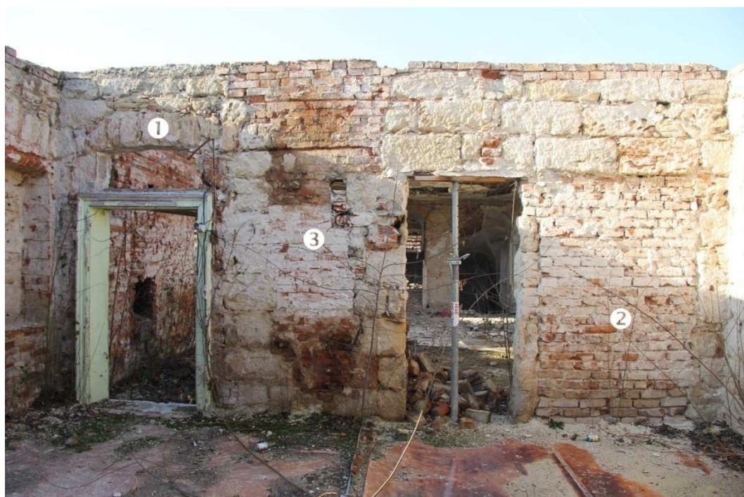
/207/ Západní stěna. ① kamenný záklenek původního vstupu. ② cihelné zdivo v místě mladšího vstupu. ③ cihelné zdi související s průlezným komínem
