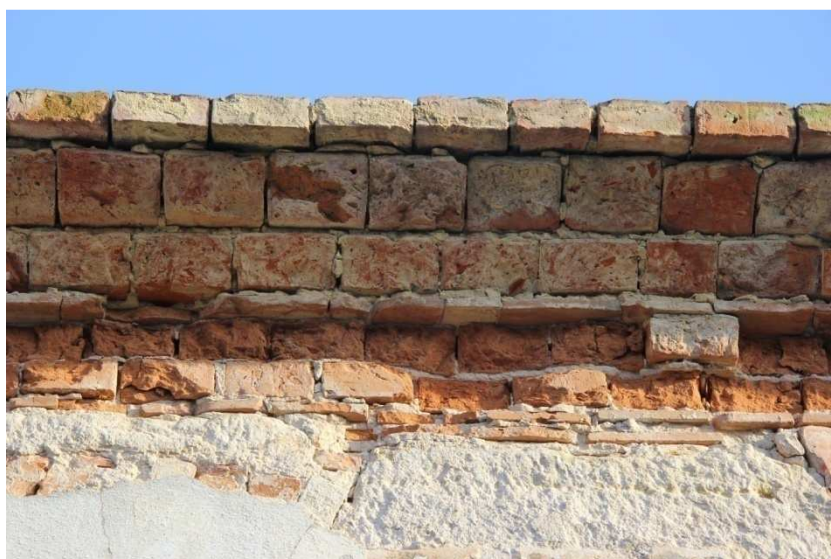
Boční křídlo, západní průčelí. Detail skladby korunní římsy
