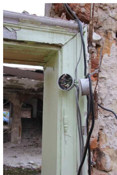
/207/ Západní stěna, levý vstup. Detaily obložkové zárubně
