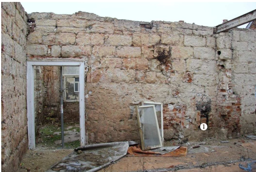
/208/ Levá polovina západní stěny. ① otvor pro napojení otopného zařízení
