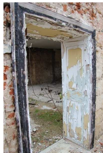
/204/ Severní stěna, úsek mezi 1. a 2. vstupem zleva. ① stopa zaniklé hloubkové zdi/příčky. ② kamenný záklenek staršího vstupu. ③ zaldívka staršího vstupu. Vpravo detail zárubně 2. vstupu zleva
