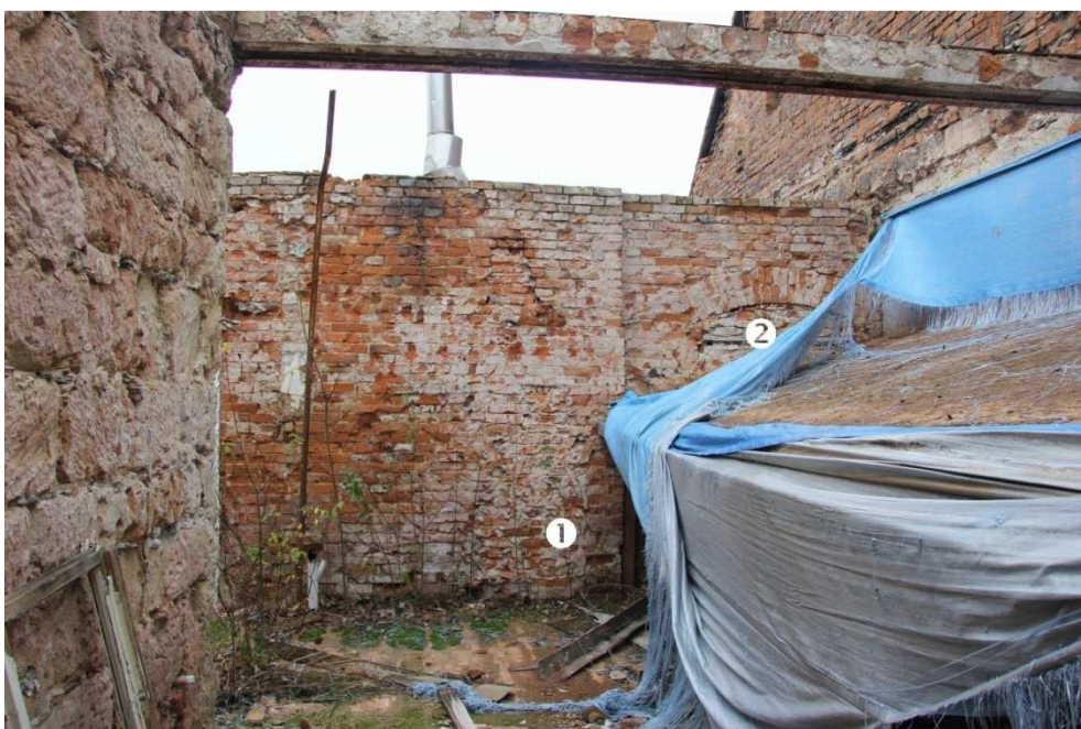
/203/ Pohled k jižní stěně. ① stopa zaniklého otvoru do komínu. ② pozice zazděného vstupu
