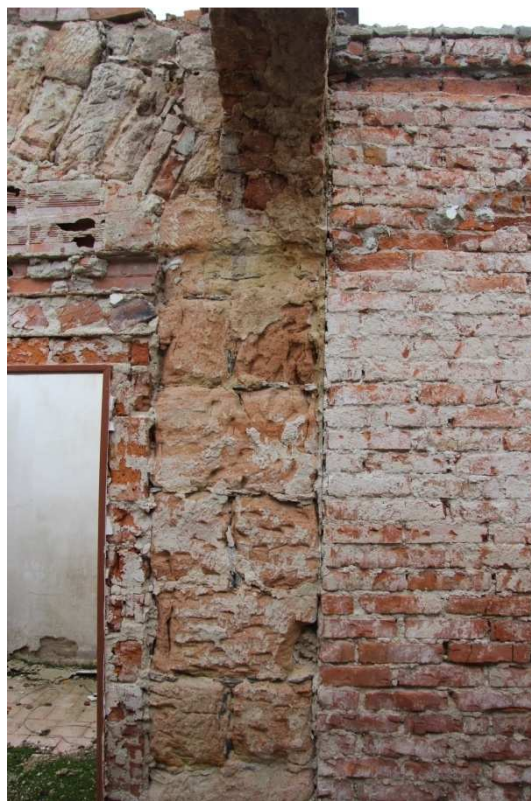
/203/ Severní stěna, východní část (vnitřní dělící zeď). Svislá spára v místě eliptického cihelného pasu
