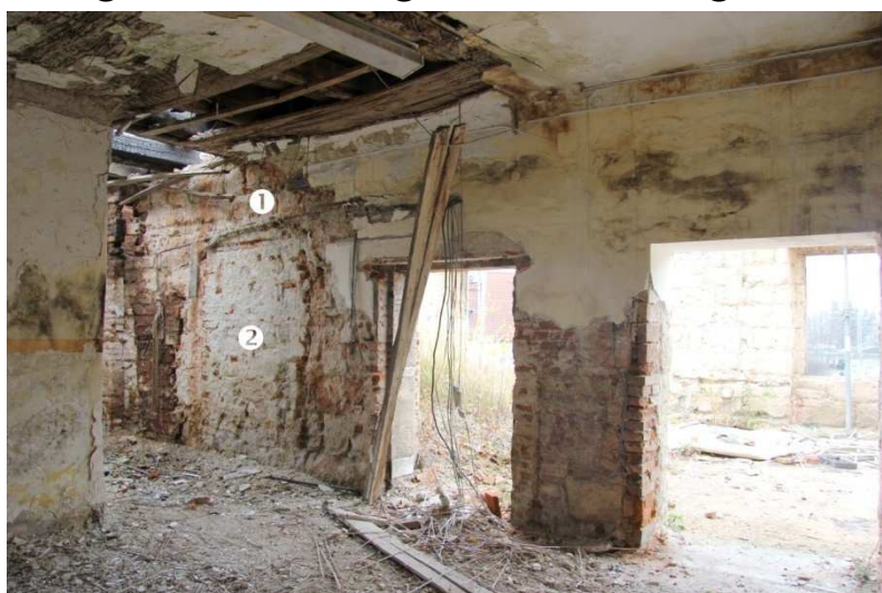
/202/ Jižní stěna, partie se 3. a 4. vstupem zprava. ① kamenný záklenek zaniklého staršího vstupu. ② zazdívka staršího zaniklého vstupu
