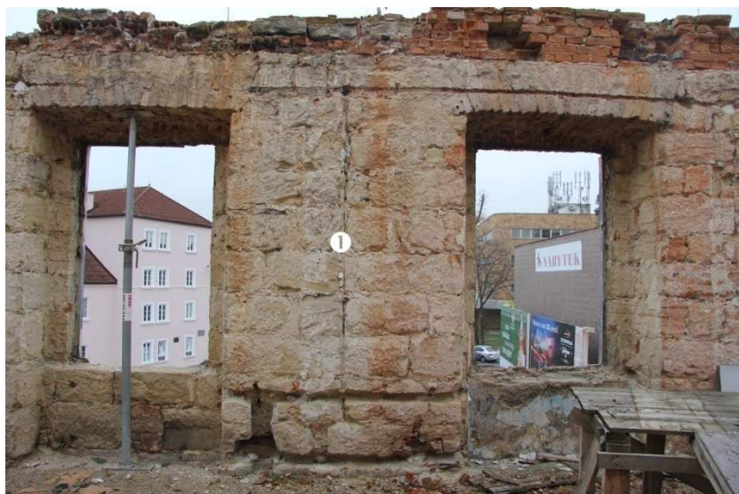
/204/ Jižní stěna. Úsek v rozsahu 7. a 8. okna zprava. ① pozice zaniklé hloubkové zdi/příčky
