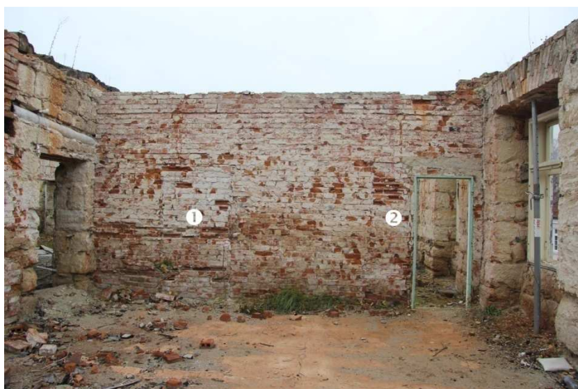
/204/ Pohled na východní stěnu. ① zazděný starší vstup. ② zdivo související se stávajícím vstupem
