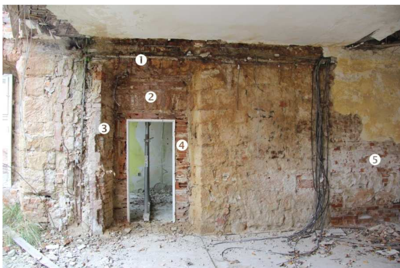
/202/ Severní stěna, partie se vstupem do 219. ① cihelný záklenek původní niky. ② cihelný záklenek mladší úpravy otvoru. ③ úprava špalety původní niky. ④ novodobá úprava vstupu. ⑤ zazděný otvor
