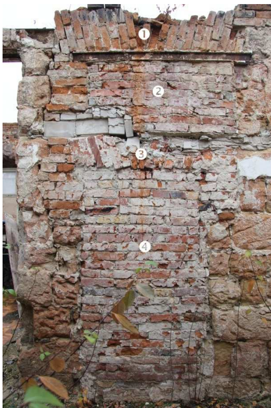
/203/ Severní stěna, východní část (vnitřní dělící zeď). Vlevo levá část stěny. ① záklenek staršího otvoru. ② cihelná zazdívka otvoru. ③ záklenek mladšího vstupu. ④ zazdívka mladšího vstupu. Vpravo pravá část stěny se vstupem do 213. ⑤ torzo kamenného pasu. ⑥ zdivo související se stávajícím vstupem
