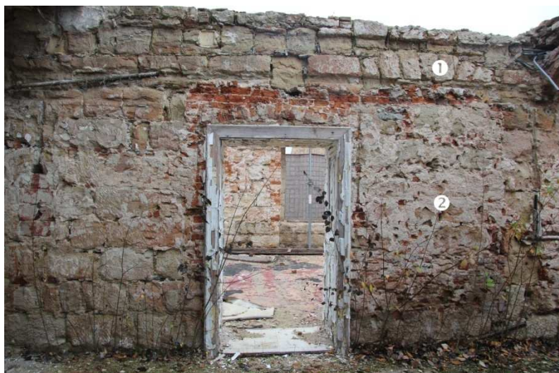
/202/ Jižní stěna, západní konec s 1. vstupem zprava. ① kamenný záklenek staršího vstupu. ② zazdívka staršího vstupu
