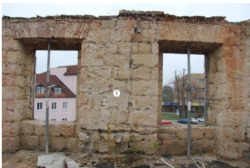
/204/ Jižní stěna. Úsek v rozsahu 9. a 10. okna zprava. ① pozice zaniklé hloubkové zdi/příčky
