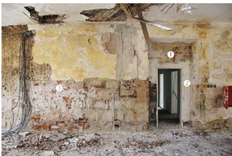
/202/ Severní stěna, partie se vstupem do 224. ① cihelný záklenek mladší úpravy otvoru. ② novodobá úprava vstupu. ③ zazděný otvor
