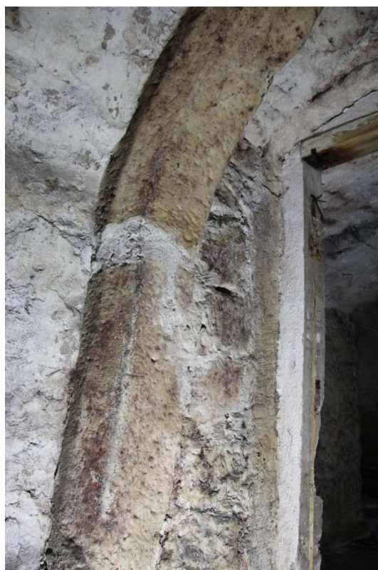
/001/ Pozdně gotický portál (portál osazený ze strany chodby). Vlevo detail jeho pravé stojky. Vpravo detail levé stojky s navazující archivoltou
