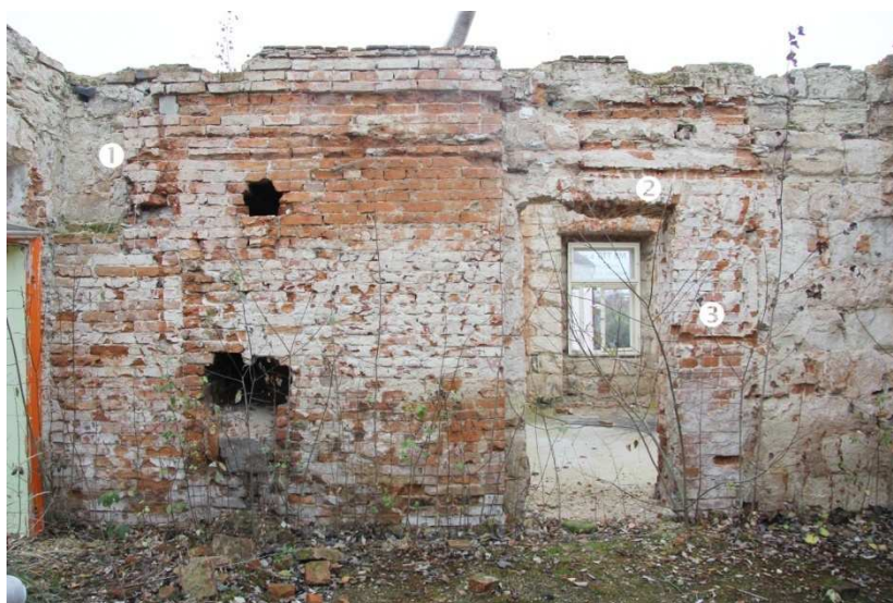
/201/ Jižní stěna, východní část. ① část původního pískovcového záklenku vstupu. ② cihelný záklenek vstupu (1. fáze). ③ mladší cihelný blok (úprava vstupu)
