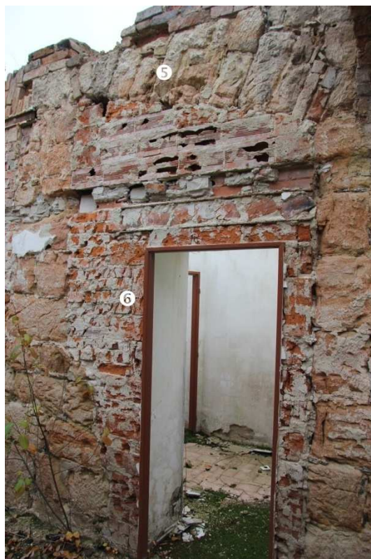
/203/ Severní stěna, východní část (vnitřní dělící zeď). Vlevo levá část stěny. ① záklenek staršího otvoru. ② cihelná zazdívka otvoru. ③ záklenek mladšího vstupu. ④ zazdívka mladšího vstupu. Vpravo pravá část stěny se vstupem do 213. ⑤ torzo kamenného pasu. ⑥ zdivo související se stávajícím vstupem
