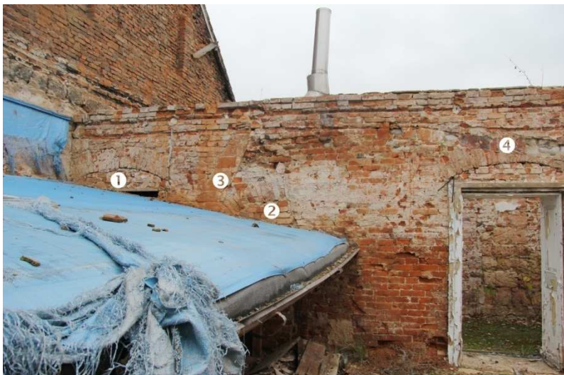
/204/ Severní stěna, západní konec. ① zalděný vstup. ② záklenek zalděného otvoru. ③ dráže kouřovodu ve zdi. ④ dráže kouřovodu ve zdi. Vpravo detail zárubně 1. vstupu zleva
