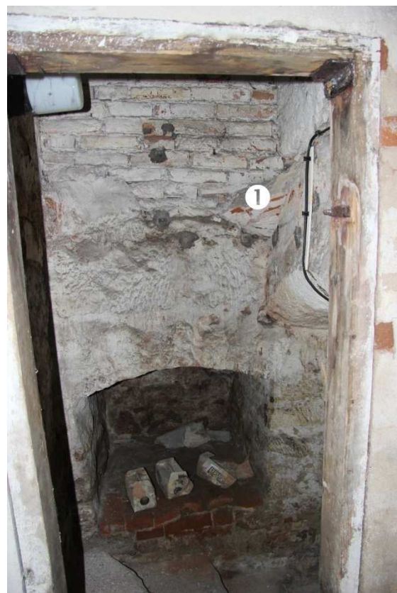
/001/ Vlevo pohled k severní stěně. Vpravo pohled na levý konec východní stěny. ① stopa zaniklé klenby
