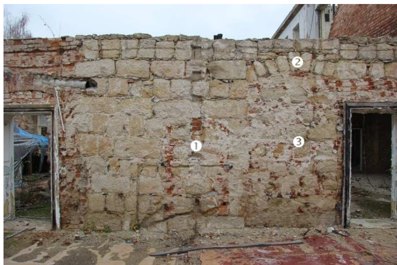
/204/ Severní stěna, úsek mezi 1. a 2. vstupem zleva. ① stopa zaniklé hloubkové zdi/příčky. ② kamenný záklenek staršího vstupu. ③ zaldívka staršího vstupu. Vpravo detail zárubně 2. vstupu zleva
