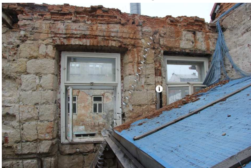
/209/ Západní stěna, pravá část. ① do zdi zasekaný průduch tahového komínu
