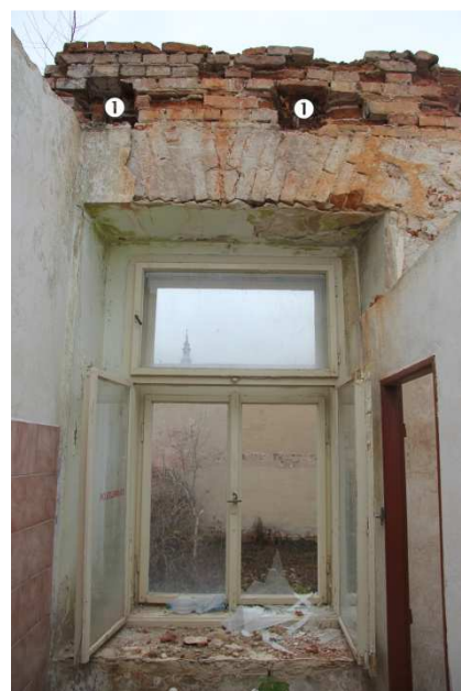
/215/ Pohled na severní stěnu. ① kapsy pro uložení stropních trámů
