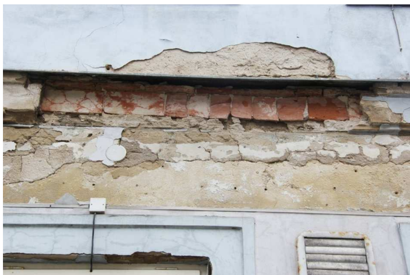
Hlavní/boční křídlo, východní průčelí. Detail skladby kordónové římsy
