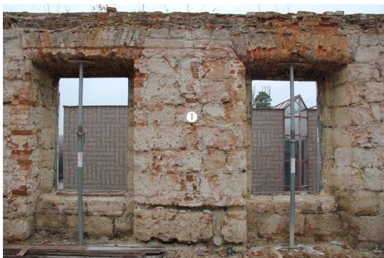
/204/ Jižní stěna. Úsek v rozsahu 3. a 4. okna zprava. ① pozice zaniklé hloubkové zdi/příčky
