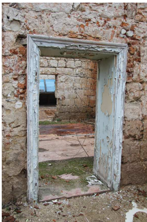
/206/ Severní stěna. ①, ② starší pískovcové záklenky. ③ zazdívka staršího vstupu. ④ cihelné zdivo vložené pod kamenný záklenek ②
