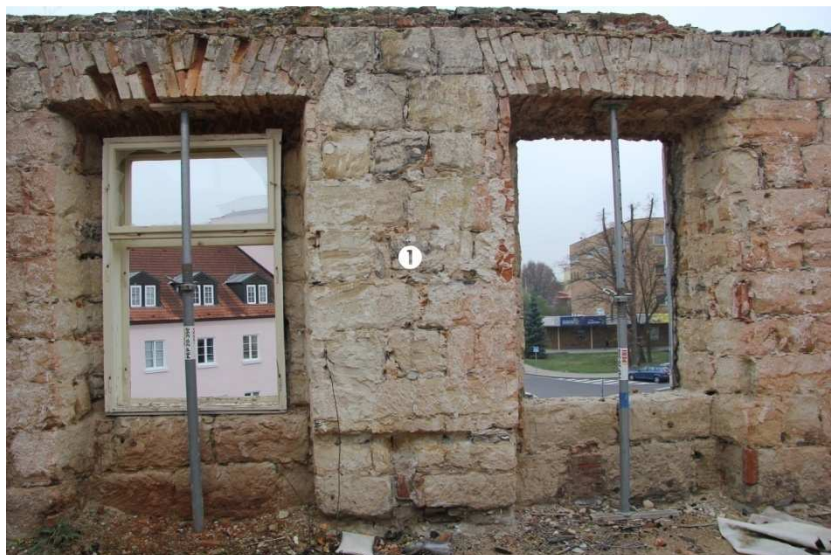
/204/ Jižní stěna. Úsek v rozsahu 11. a 12. okna zprava. ① pozice zaniklé hloubkové zdi
