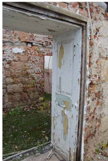
/204/ Severní stěna, západní konec. ① zalděný vstup. ② záklenek zalděného otvoru. ③ dráže kouřovodu ve zdi. ④ dráže kouřovodu ve zdi. Vpravo detail zárubně 1. vstupu zleva
