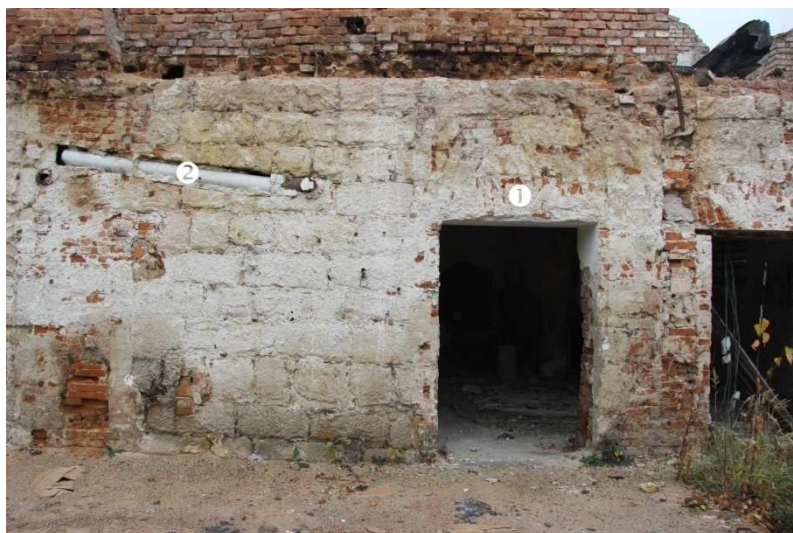
/204/ Severní stěna, úsek vlevo od 4. vstupu zleva (vpravo část 5. vstupu). ① cihelný záklenek vstupu. ② dráže ve zdi s rourou kouřovodu
