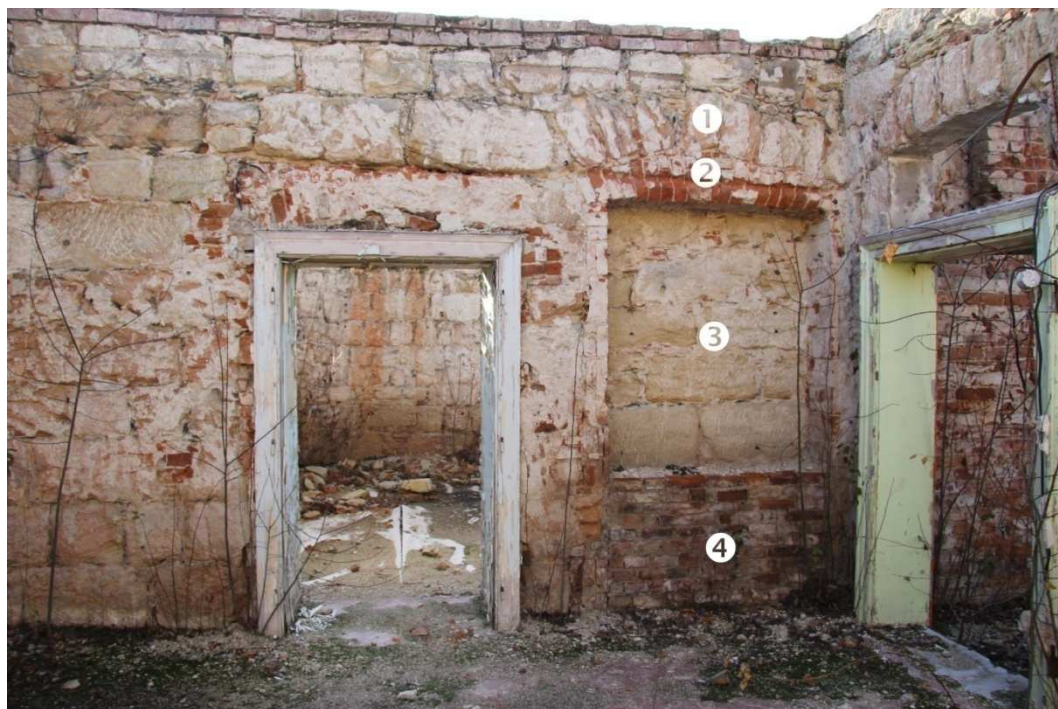
/207/ Jižní stěna. ① kamenný záklenek původního vstupu. ② mladší cihelný záklenek související se zřízením mladší niky. ③ zadržka původního vstupu. ④ sekundární zdivo parapetu niky
