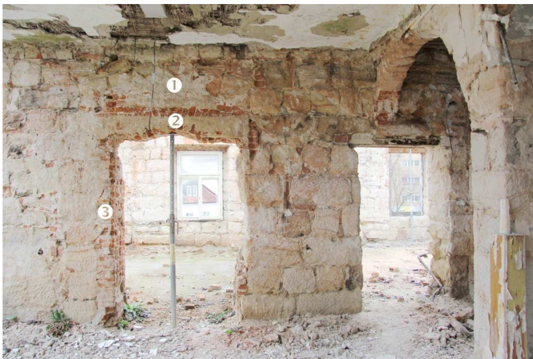
/201/ Jižní stěna, východní část. ① starší záklenek z pískovců. ② mladší cihelný záklenek vstupu. ③ cihelná úprava špalety vstupu (současná s cihelným záklenkem)
