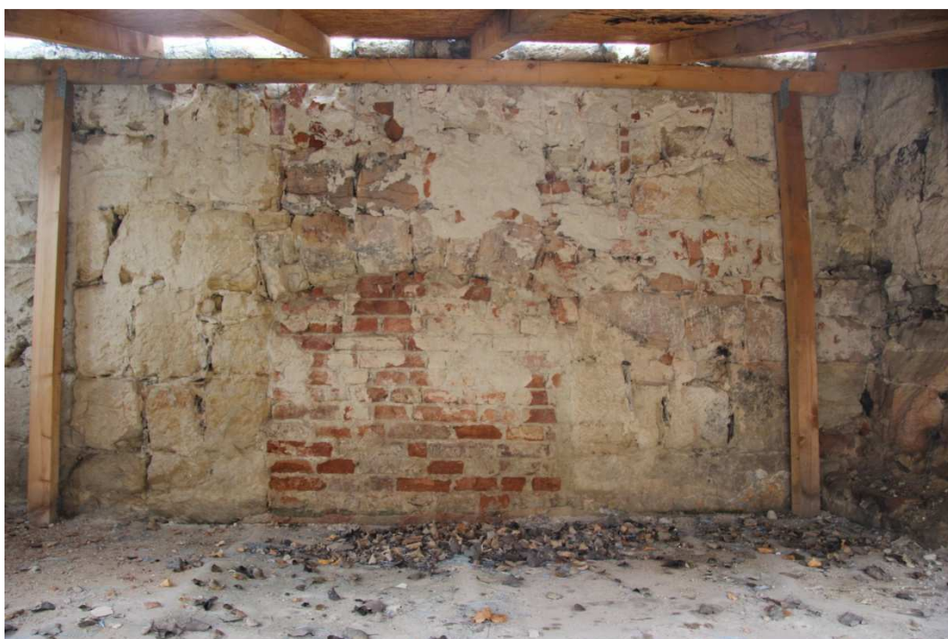
/209/ Severní stěna, dolní partie se zazděným otvorem, či nikou
