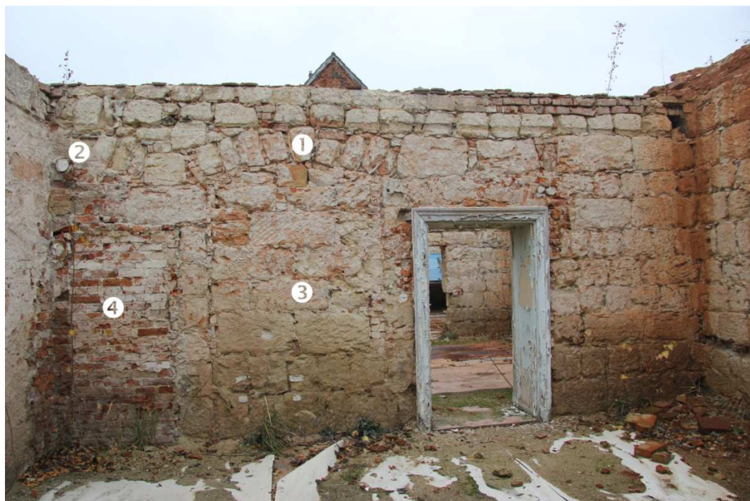
/206/ Severní stěna. ①, ② starší pískovcové záklenky. ③ zazdívka staršího vstupu. ④ cihelné zdivo vložené pod kamenný záklenek ②
