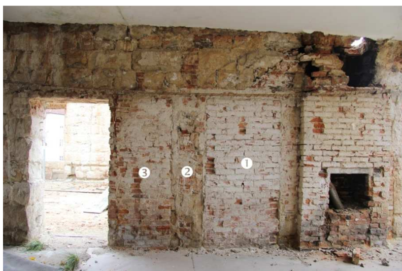
/202/ Jižní stěna. Partie mezi 1. a 2. vstupem zprava. ① zazděný sekundární vstup. ② stopy po odstraněné hloubkové zdi. ③ blok cihelného zdiva souvisejícího s úpravou 2. vstupu zprava (otvor na snímku vlevo)
