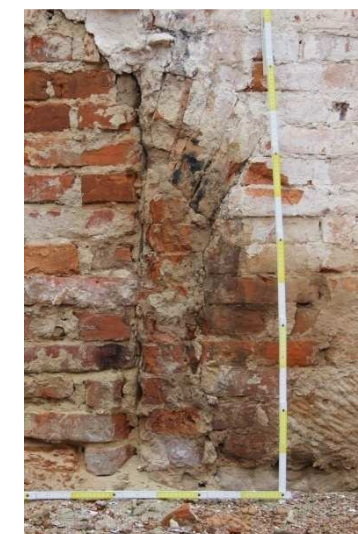
/204/ Severní stěna, úsek vpravo od 2. vstupu zleva. ① stopa zaniklé hloubkové zdi. ② mladší cihelné zdivo. ③ fragment otvoru pro napojení otopného zařízení. Vpravo detail situace ③
