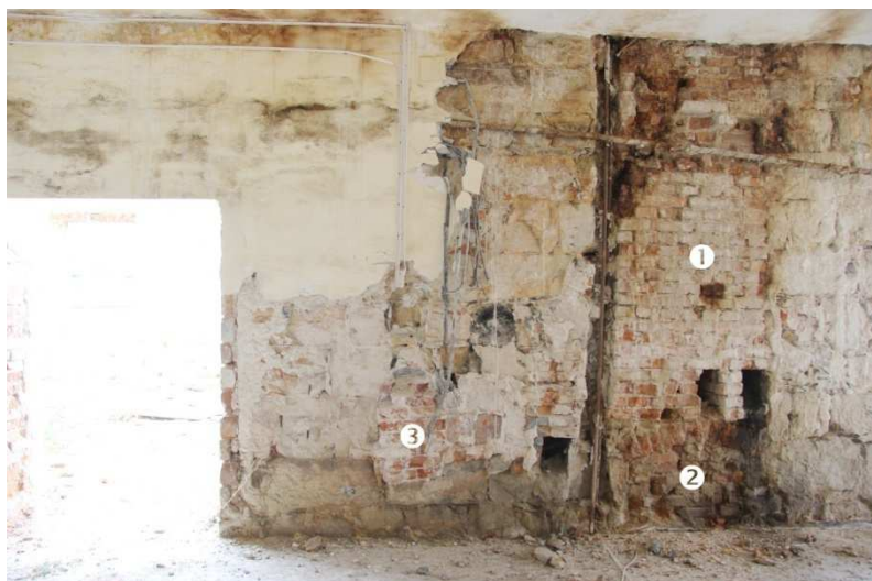
/202/ Jižní stěna, partie vpravo od 3. vstupu zprava (otvor na snímku vlevo). ① cihelné zdivo komína. ② starší otvor do komína. ③ zazděná nika
