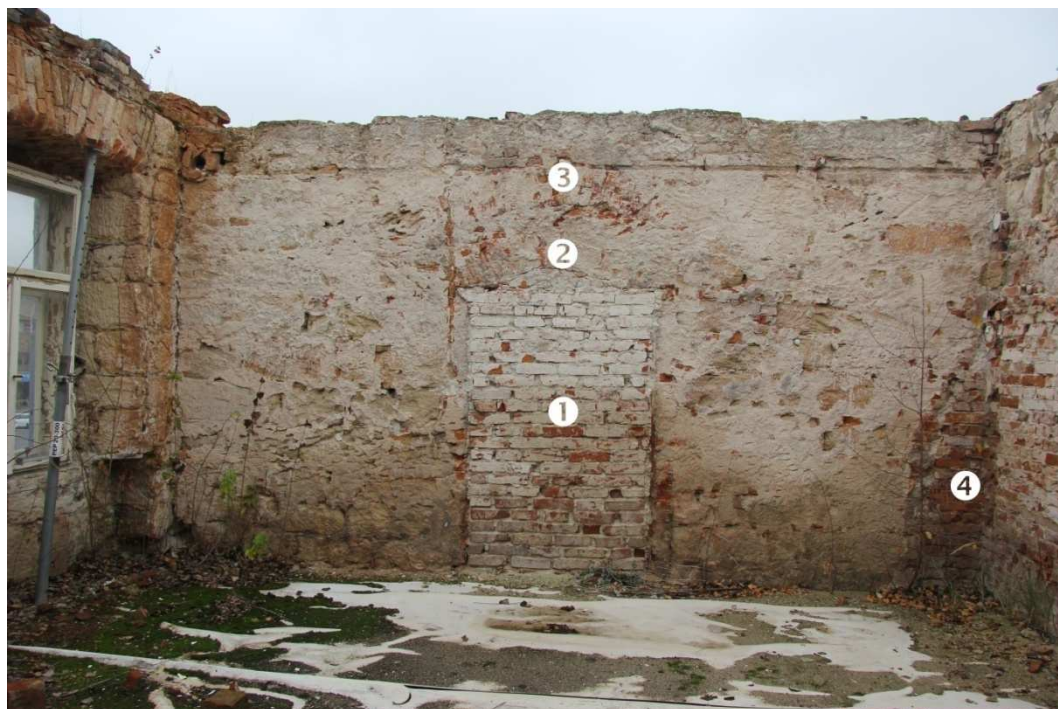
/206/ Západní stěna. ① zazděný vstup do místnosti 205. ②, ③ cihelné záklenky nad vstupem. ④ mladší cihelné zdivo
