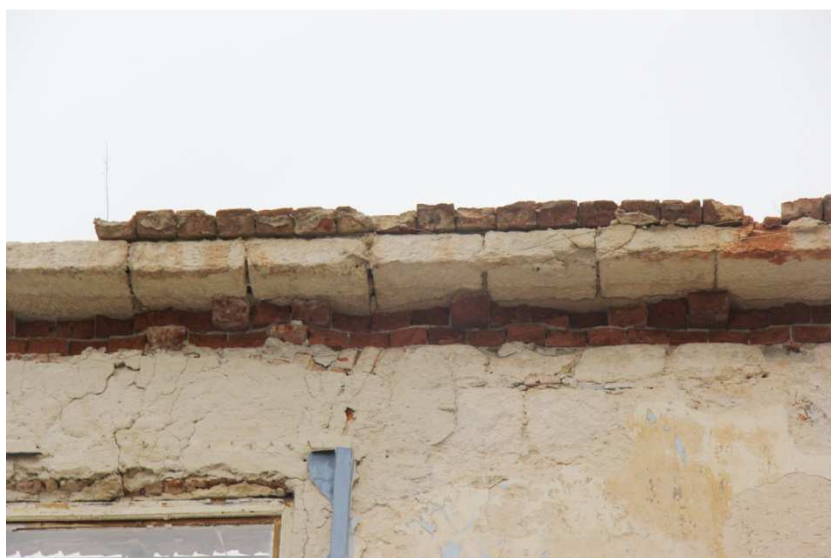
Hlavní/boční křídlo, východní průčelí. Detail skladby korunní římsy
