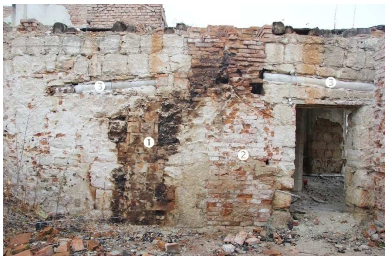
/204/ Severní stěna, úsek vlevo od 6. vstupu zleva (6. vstup zcela vpravo). ① mladší cihelná úprava líce. ② mladší cihelné zdivo. ③ dráže ve zdi s rourami kouřovodů
