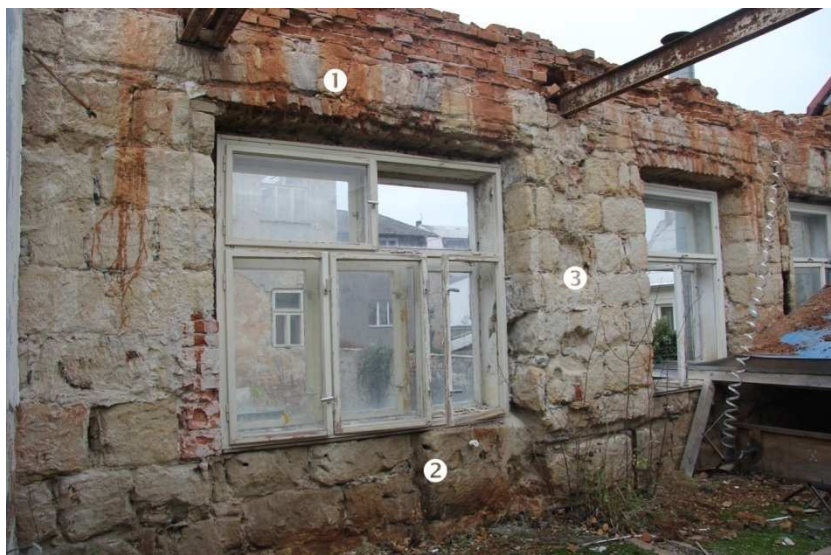
/209/ Západní stěna. ① cihelný záklenek niky původního okna. ② torzo pravé špalety niky původního okna. ③ pozice zaniklé vnitřní dělicí zdi
