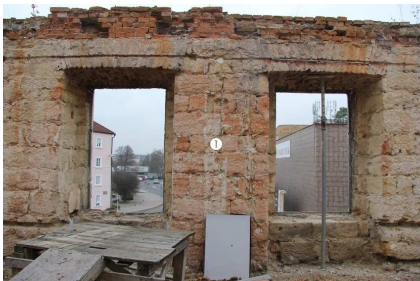
/204/ Jižní stěna. Úsek v rozsahu 6. a 7. okna zprava. ① pozice zaniklé hloubkové příčky
