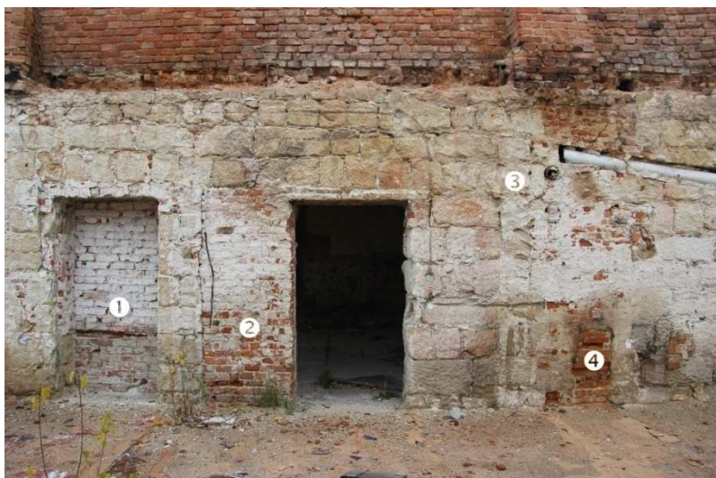
/204/ Severní stěna v okolí 3. vstupu zleva. ① zazděný vstup. ② cihelný blok zdiva související se 3. vstupem zleva. ③ stopa zaniklé hloubkové zdi. ④ fragment otvoru pro napojení otopného zařízení. Vpravo detail situace ④
