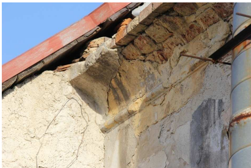
Boční křídlo, západní průčelí. Detail profilace korunní římsy
