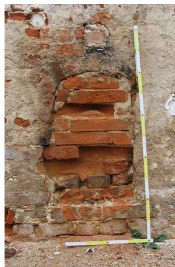
/204/ Severní stěna v okolí 3. vstupu zleva. ① zazděný vstup. ② cihelný blok zdiva související se 3. vstupem zleva. ③ stopa zaniklé hloubkové zdi. ④ fragment otvoru pro napojení otopného zařízení. Vpravo detail situace ④
