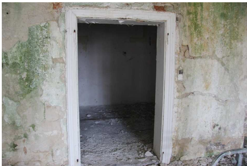
/222/ Východní stěna. Detail vstupu do 223 s obložkovou zárubní
