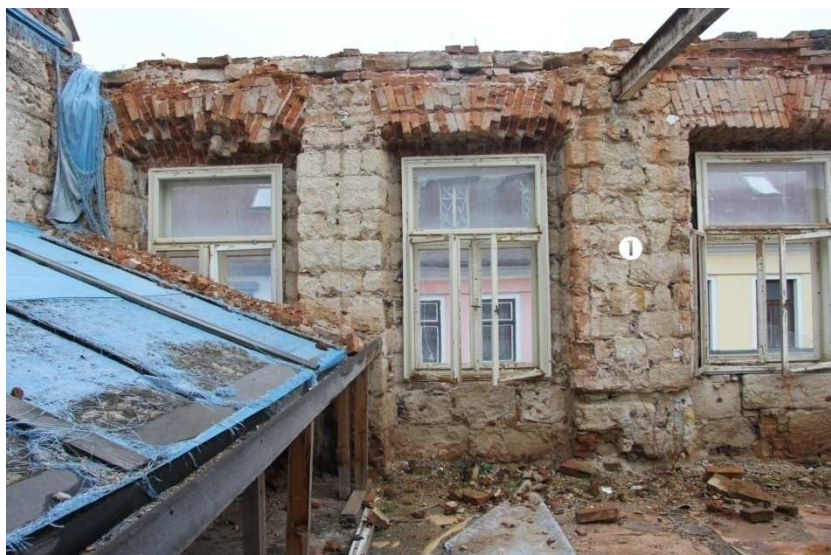
/208/ Východní stěna (první 3 okna od severu). ① pozice odstraněné původní vnitřní dělicí zdi
