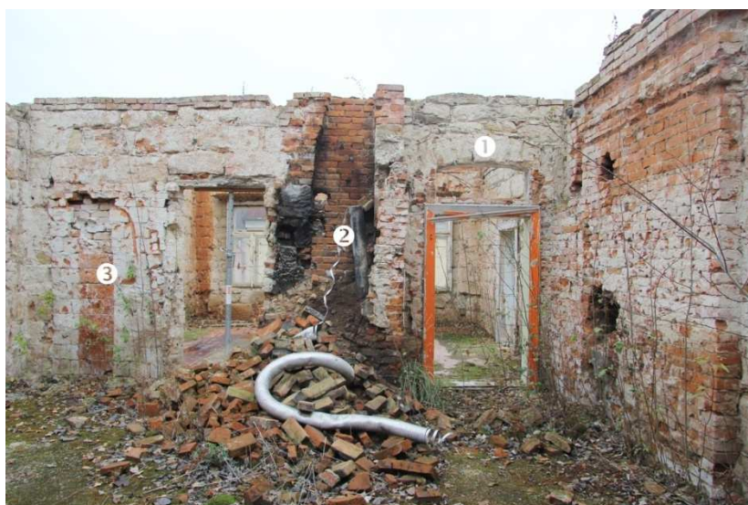
/201/ Východní stěna. ① starší pískovcový záklenek. ② torzo komínu. ③ zazděný sekundární vstup
