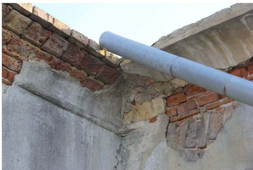
Boční křídlo, západní průčelí. Styk korunních říms bočního křídla a navazujícího severního průčelí křídla hlavního
