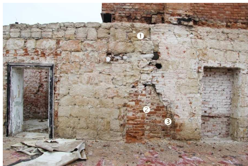
/204/ Severní stěna, úsek vpravo od 2. vstupu zleva. ① stopa zaniklé hloubkové zdi. ② mladší cihelné zdivo. ③ fragment otvoru pro napojení otopného zařízení. Vpravo detail situace ③
